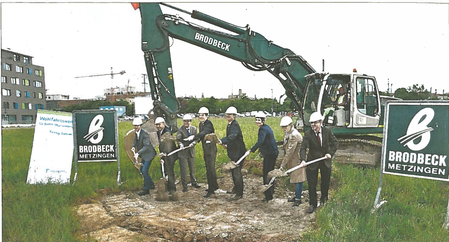
Spatenstich für das Wohn- und Pflegezentrum „Domizil am See“ auf dem Flugfeld
