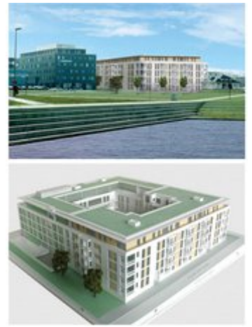
Das KIAG Großprojekt am Flugfeld Böblingen-Sindelfingen.
